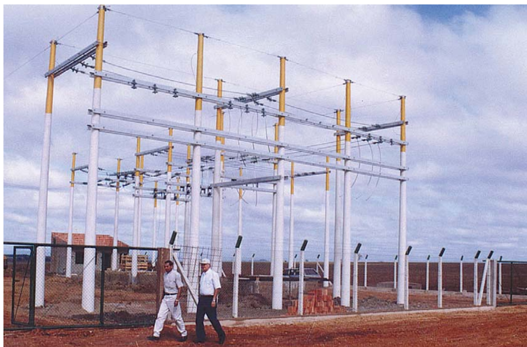
Os gerentes João Pereira e Hugo Ferraz visitam as obras da subestação do Cercadinho
